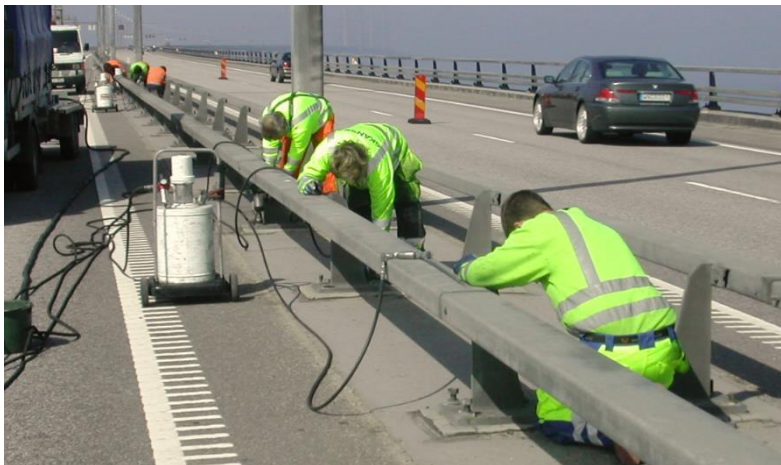
Åtgärden blev att under 3 sommarmånader 2005 behandla brons alla 24 000 räckebultar med Noxudol 700.
